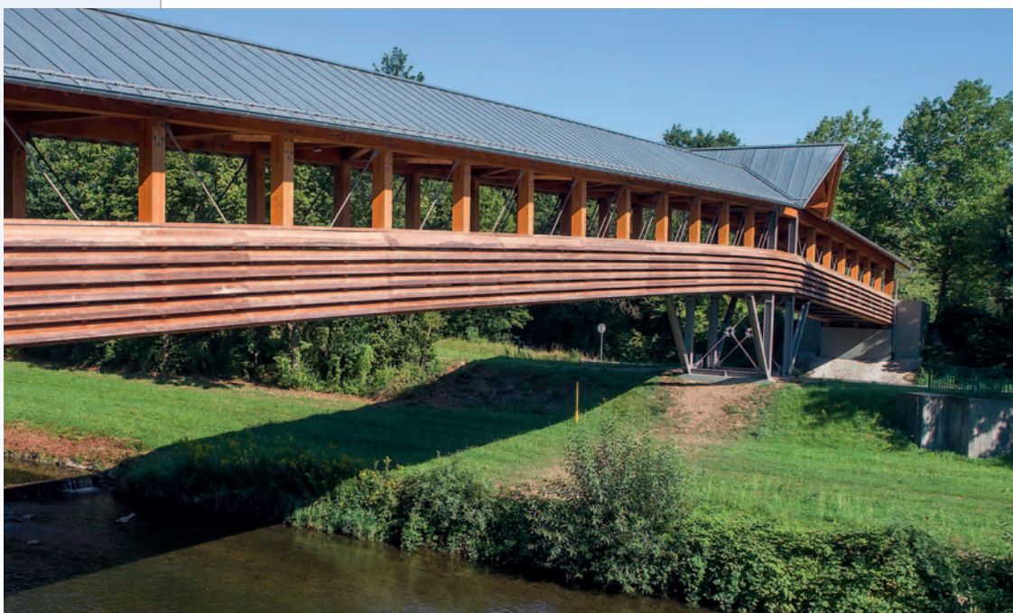
Fußgänger- und Radbrücke, Lörrach
