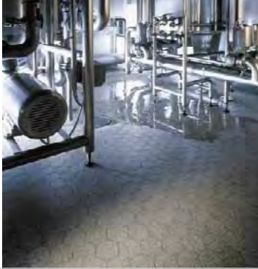
Abb. 25 und 26: Rüttelboden nach AGI S 40 (oben) und mit Detailaus- bildung Bodenablauf (unten)
