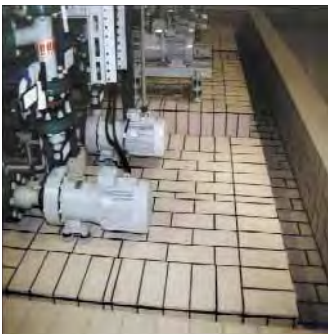
Abb. 21 und 22: Kombiniertes Belag in einem Technikum (oben) und einer Pumpenstation (unten)
