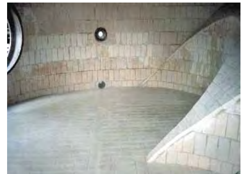
Abb. 16: Blick auf den Boden eines Bleichturms
