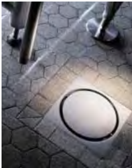
Abb. 25 und 26: Rüttelboden nach AGI S 40 (oben) und mit Detailaus- bildung Bodenablauf (unten)
