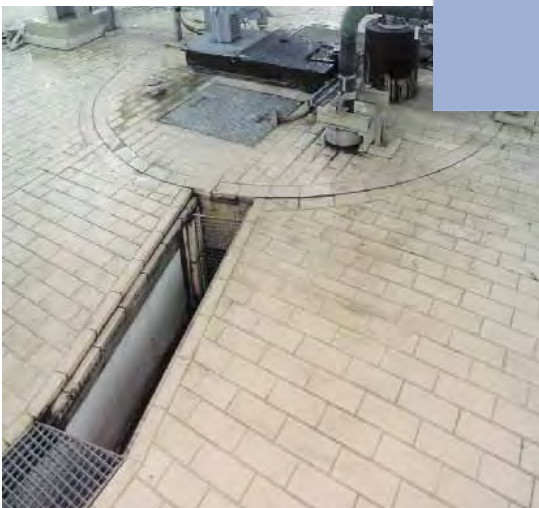
Abb 24: Beständiger Plattenbelag im Kraftwerksbereich (Gitterrost zur Demonstration entfernt)
