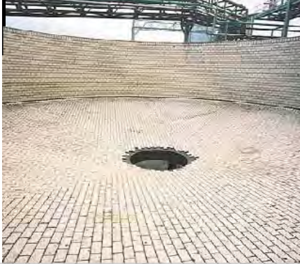
Abb. 17 und 18: Eindicker mit keramischer Ausmauerung
