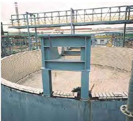
Abb. 17 und 18: Eindicker mit keramischer Ausmauerung
