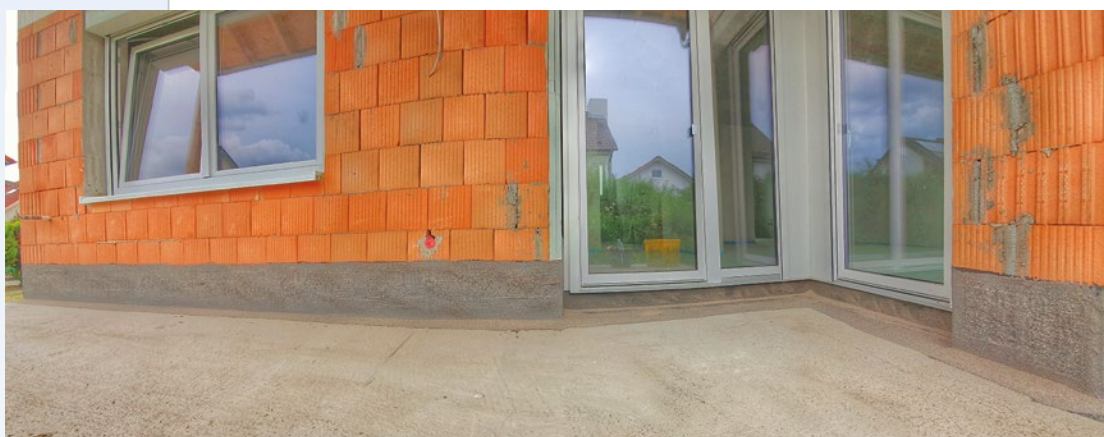
Gebäudesockel- und Türabdichtung mit FPD
