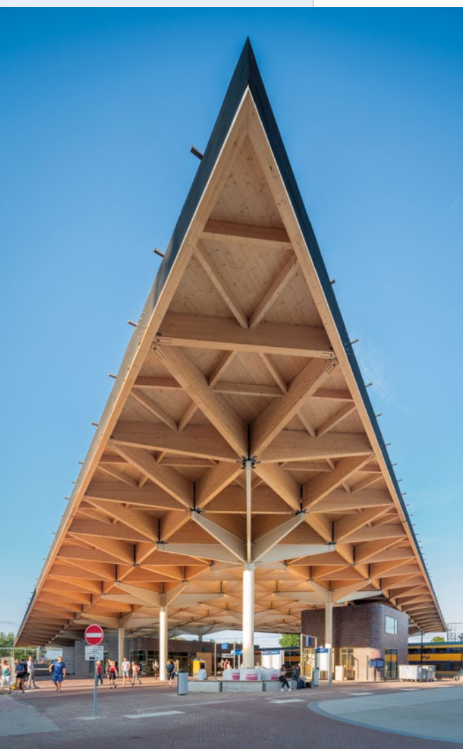
Bahnhofsüberdachung in Assen
