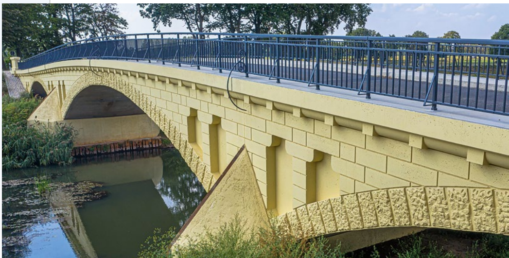
Instandsetzung der Elster-Brücke bei Neudeck Deutscher Brückenbaupreis 2020
