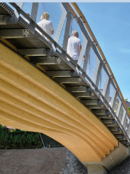
Holzbrücke in Weinstadt Deutscher Brückenbaupreis 2020
