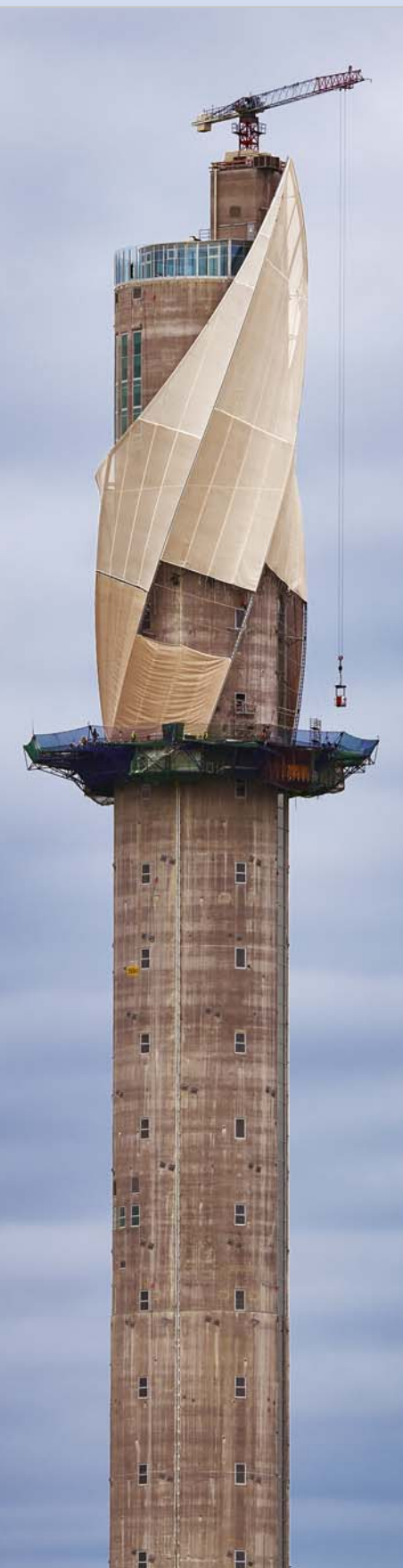
ThyssenKrupp Testturm, Rottweil
