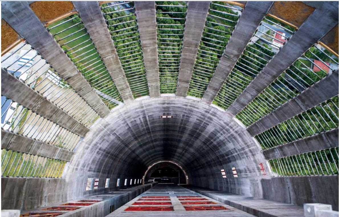
ThyssenKrupp Testturm, Rottweil
