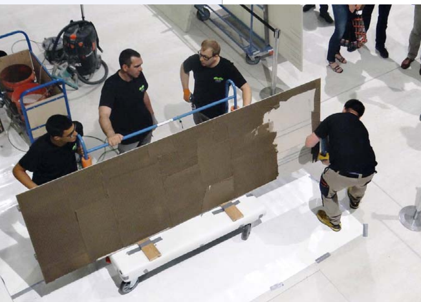
Aufziehen eines Kammbettes für eine Fliese von 3 m × 1 m
