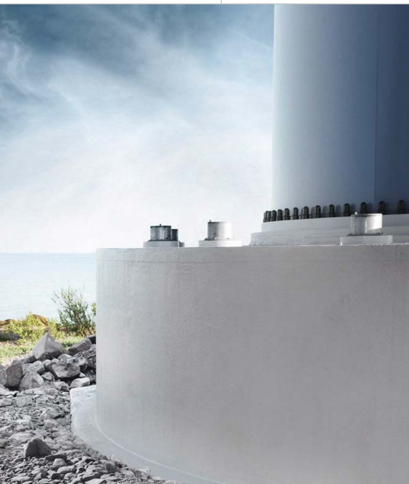
Abdichtung Fundament
