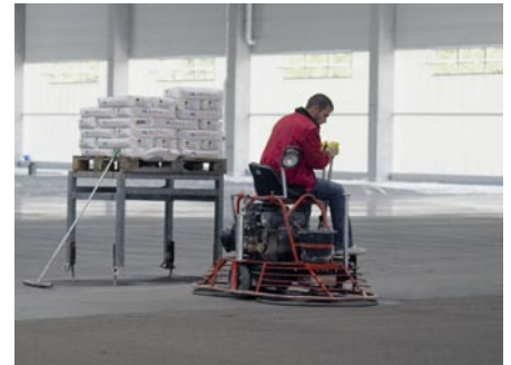
Glätten des Betons für einen Industrieboden
