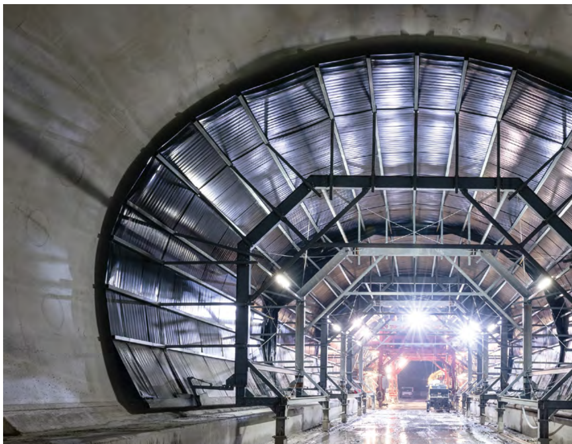
Innenschalenbeton Brenner Basistunnel
